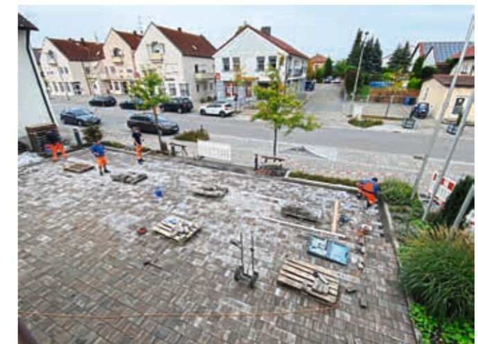
Pflasterarbeiten Parkplatz Rathaus Aiterhofen
